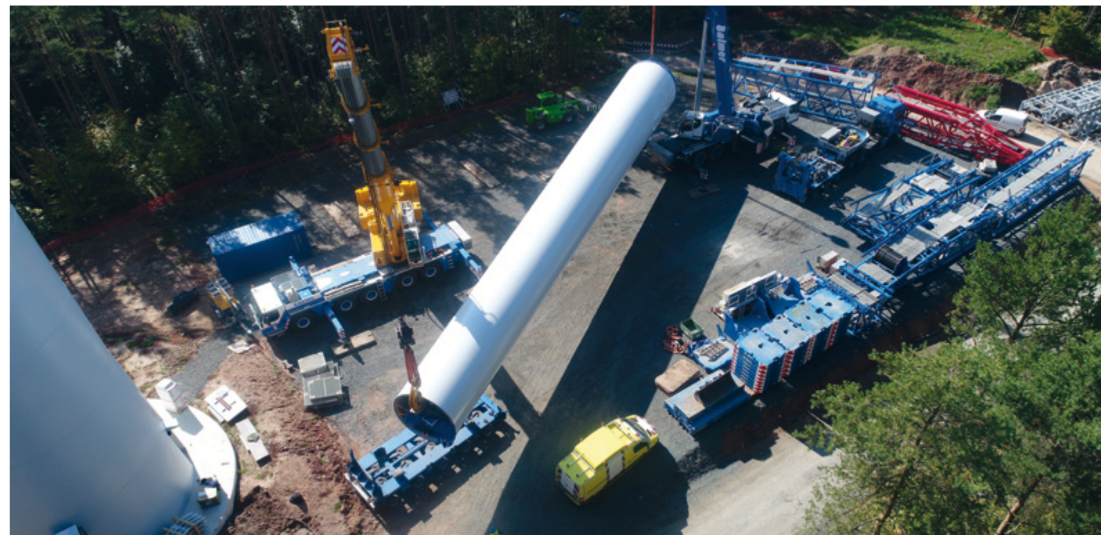
Der Stahlturm wird angeliefert.
