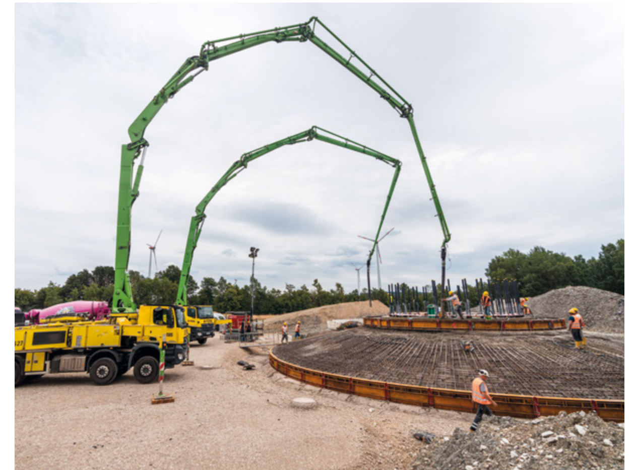
Betonage des Fundaments
