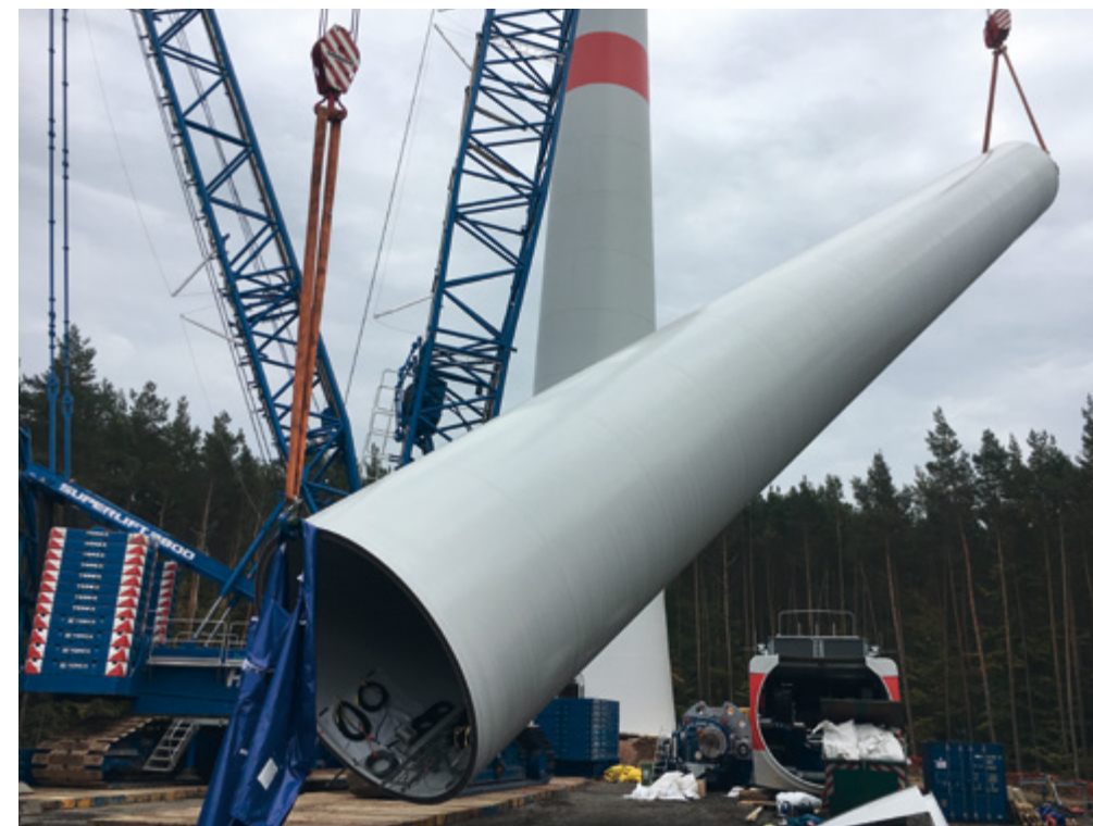
Montage eines Stahlturms
