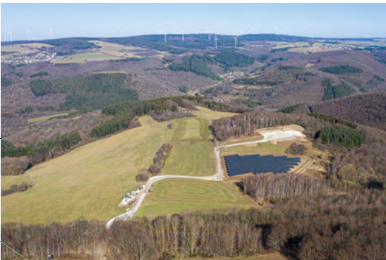
Windpark Gielert Inbetriebnahme vorauss. Ende 2021 2 Anlagen (1 Gielert, 1 Zweckverband der 12 Gemeinden)
