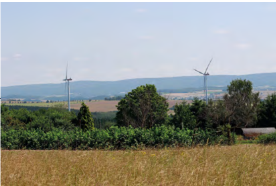
Windpark Merschbach Inbetriebnahme 2017 2 Anlagen (Merschbach)
