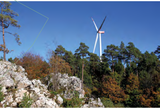
Windpark Berger Wacken Inbetriebnahme 2017 2 Anlagen (Berglicht)
