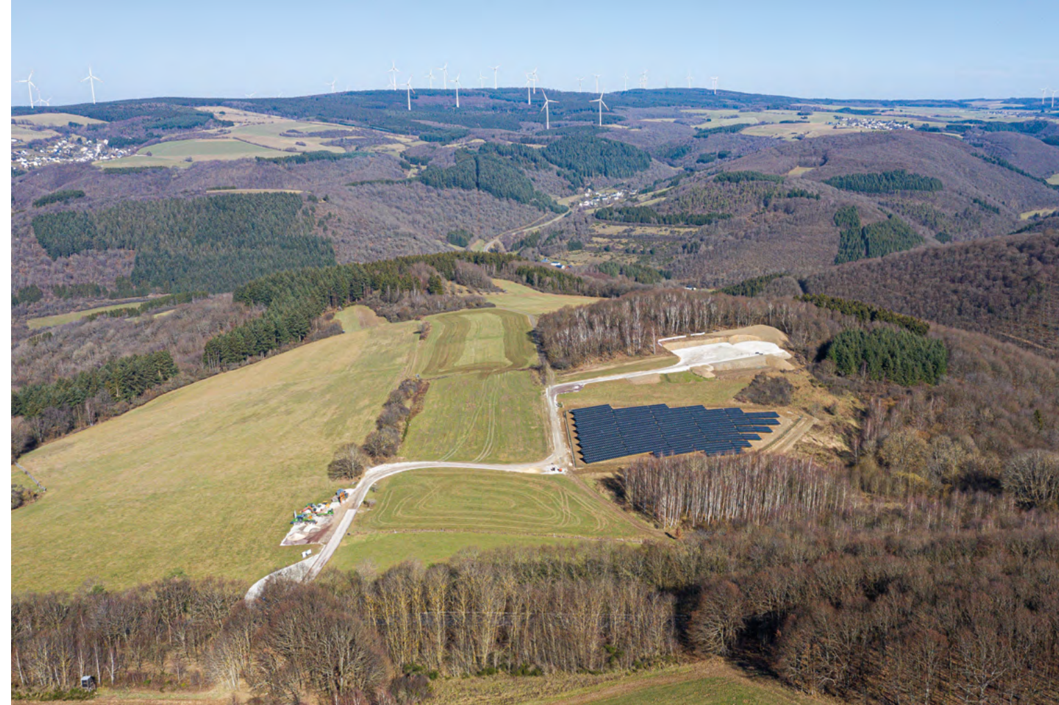
Energiepark Gielert: Solarpark seit März 2021 am Netz, der Windpark folgt bis Ende des Jahres
