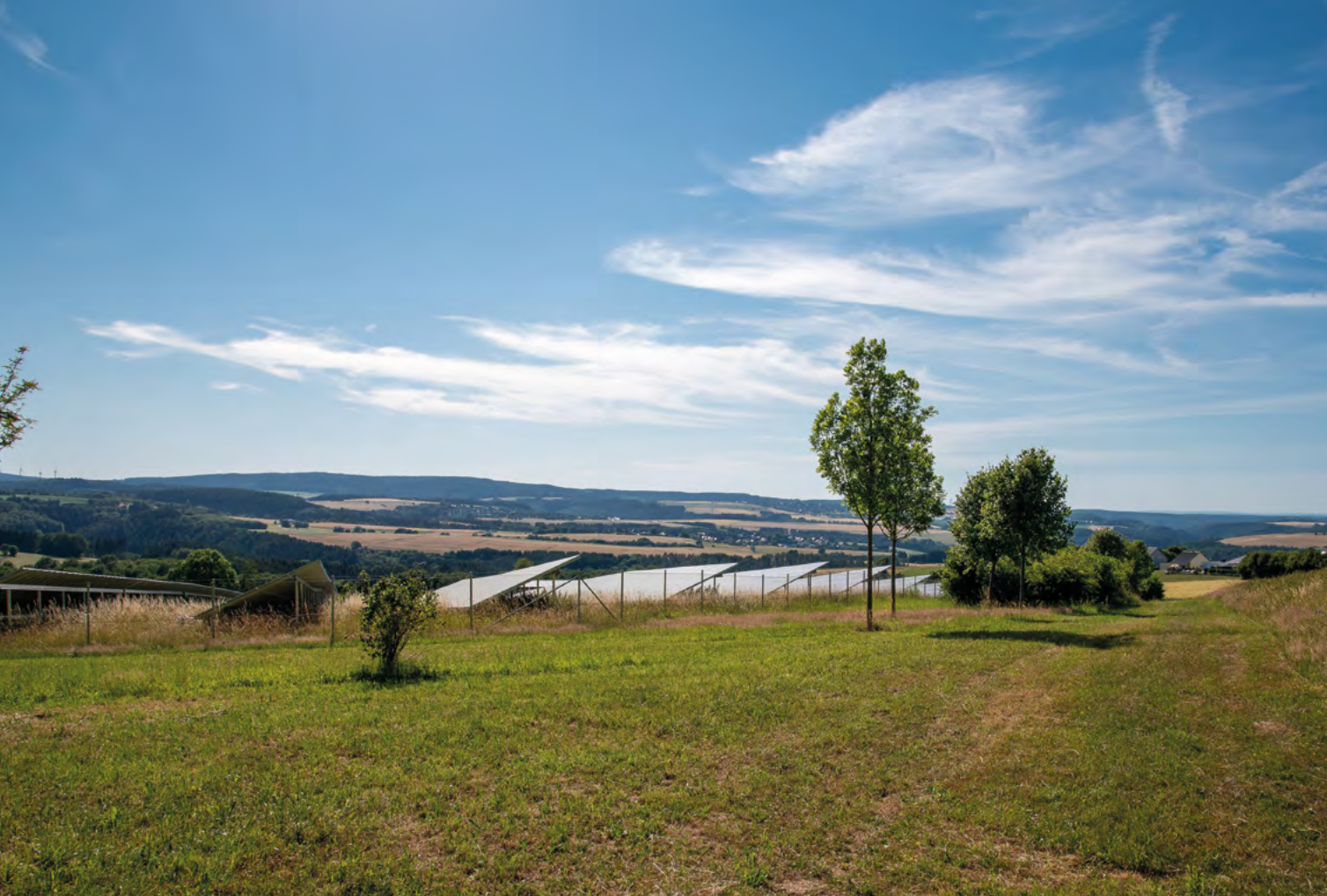
Solarpark Malborn, Inbetriebnahme 2018
