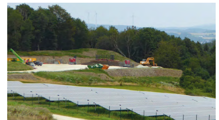
Die Fundamente der beiden Windkraftanlagen wurden im Sommer 2021 errichtet
