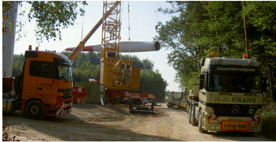
Bau des Windparks Talling im Jahr 2005
