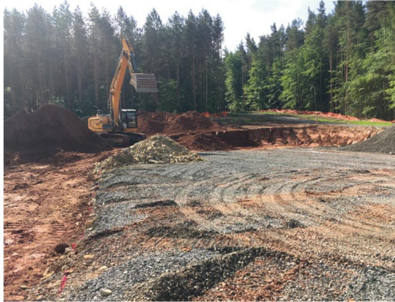
Der Standort wird für den Fundamentbau vorbereitet.
