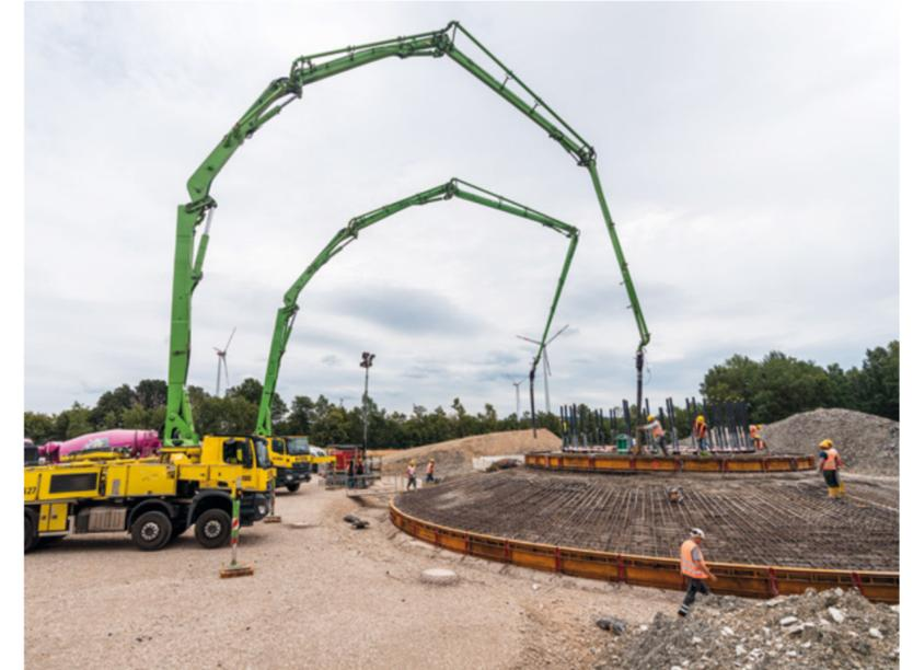
Betonage des Fundaments
