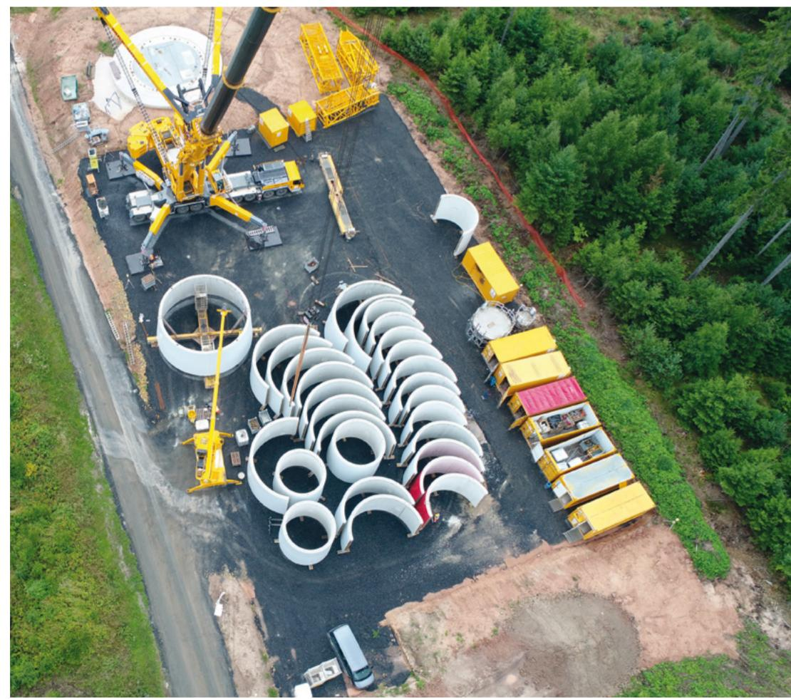
Die Betonteile des Beton-Stahl-Hybridturms werden auf dem Kranstellplatz gelagert.
