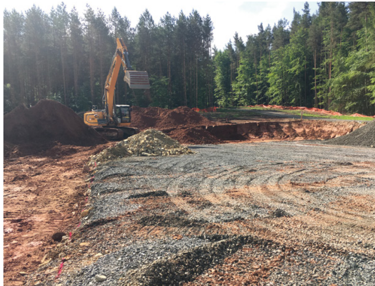
Der Standort wird für den Fundamentbau vorbereitet.
