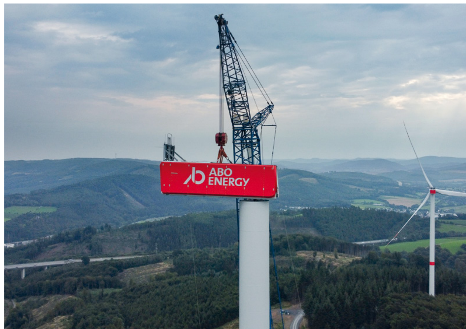
Montage des Maschinenhauses
