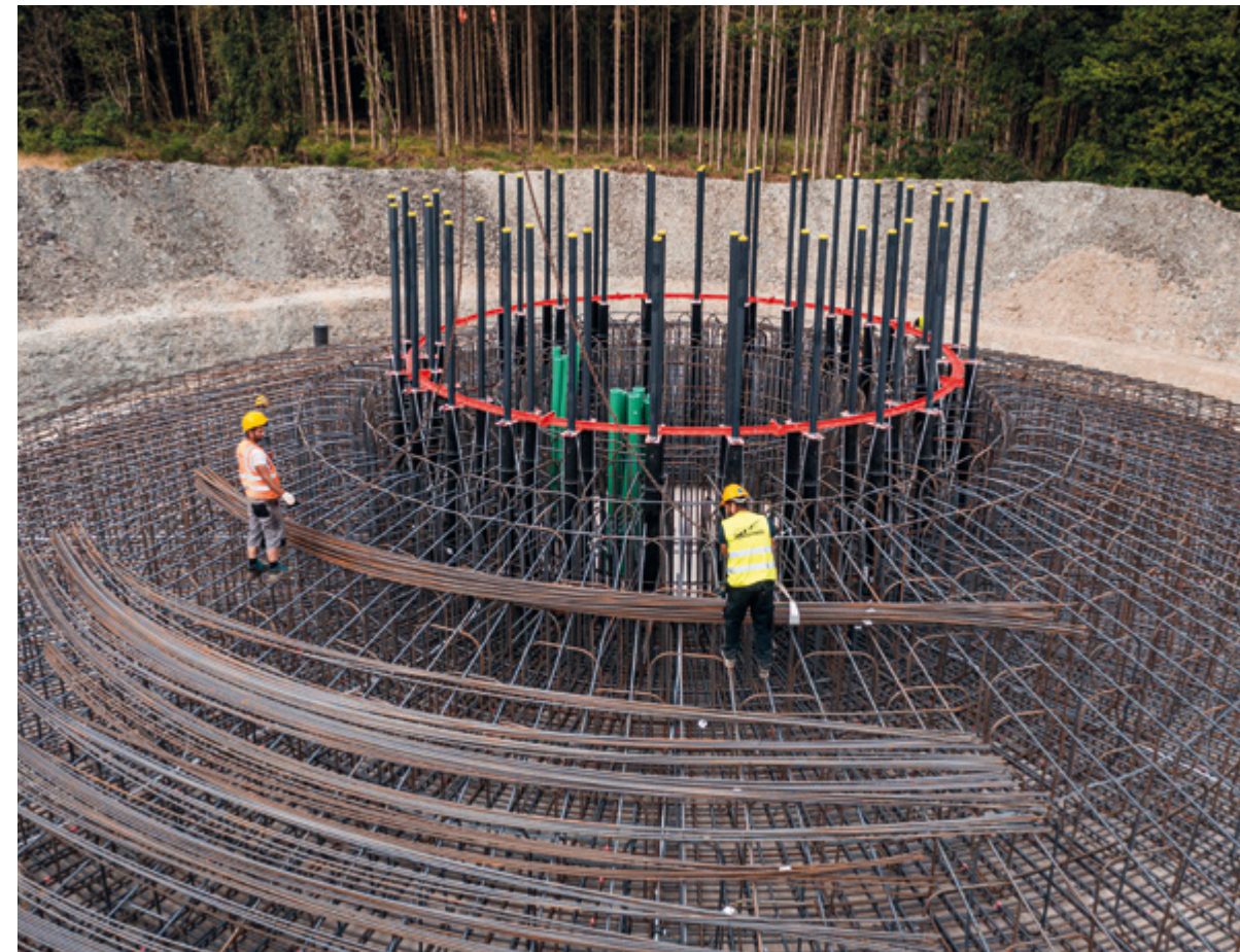
Der Fundamentkorb wird geflochten.
