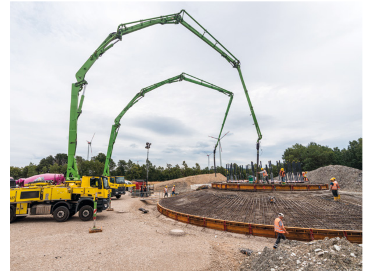
Betonage des Fundaments
