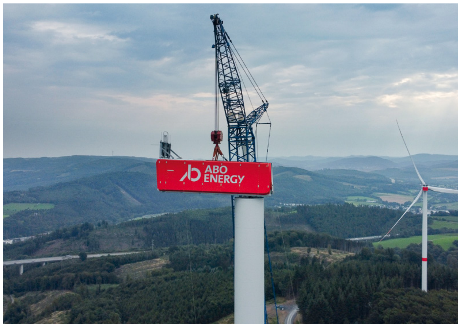
Montage des Maschinenhauses
