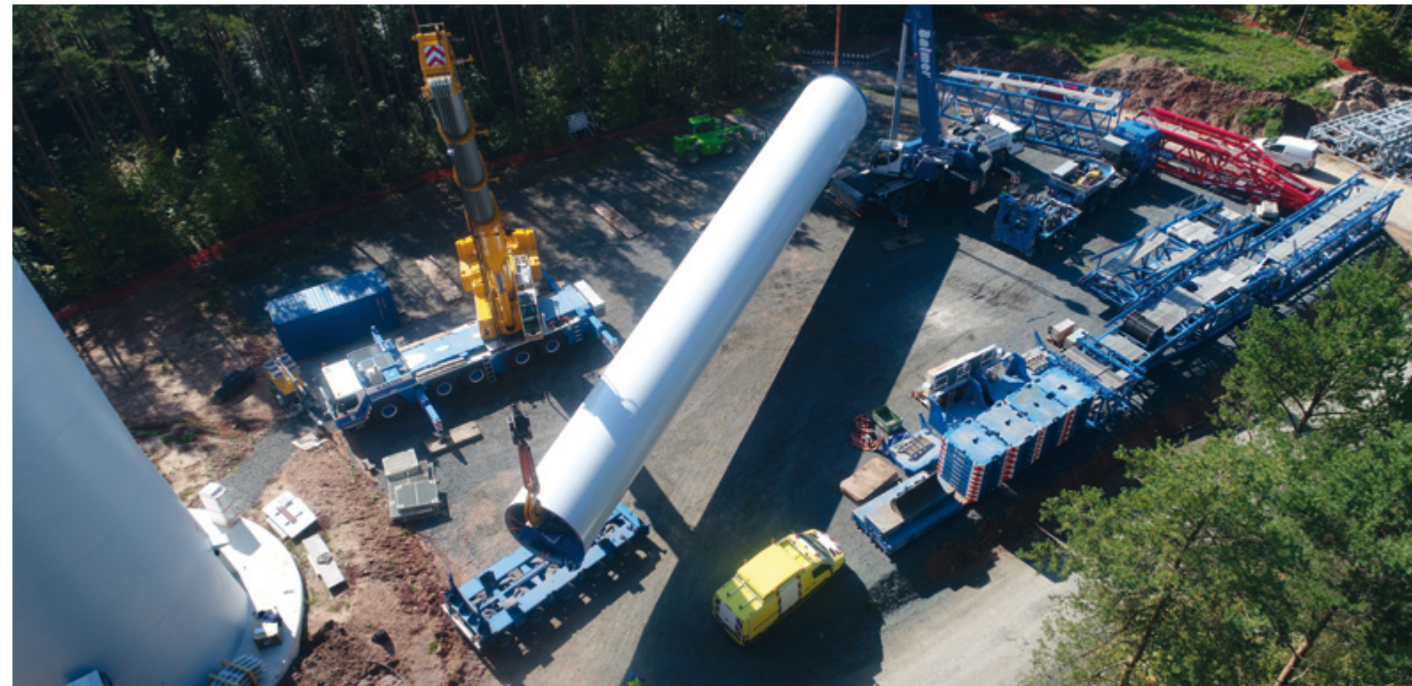
Der Stahlturm wird angeliefert.
