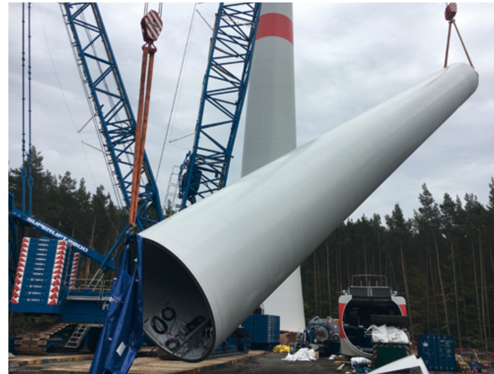
Montage eines Stahlturms
