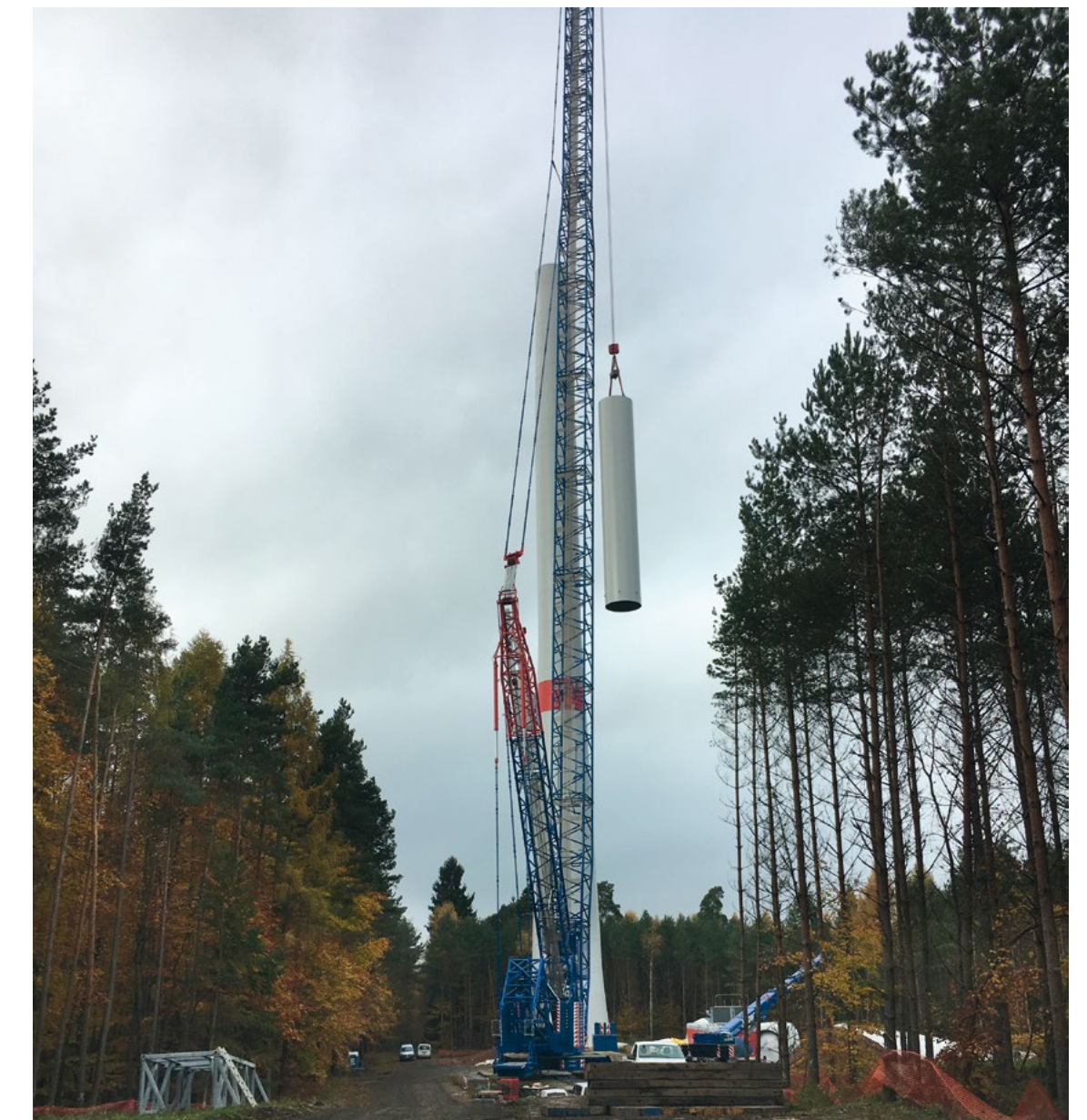
Mit zwei Stahlturmsegmenten erreicht die Anlage ihre endgültige Höhe.
