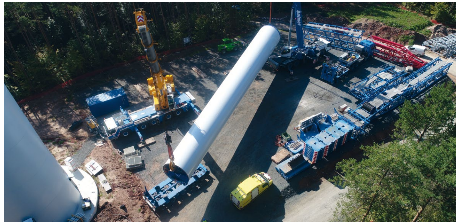
Der Stahlturm wird angeliefert.
