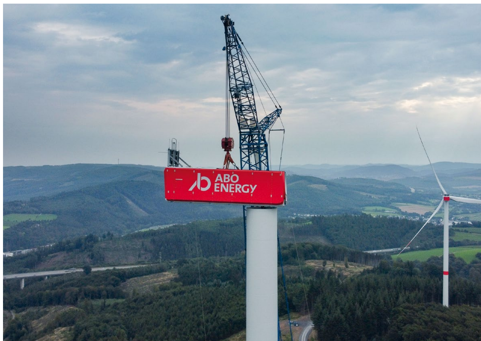
Montage des Maschinenhauses
