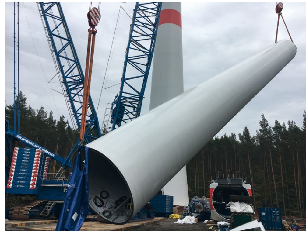
Montage eines Stahlturms
