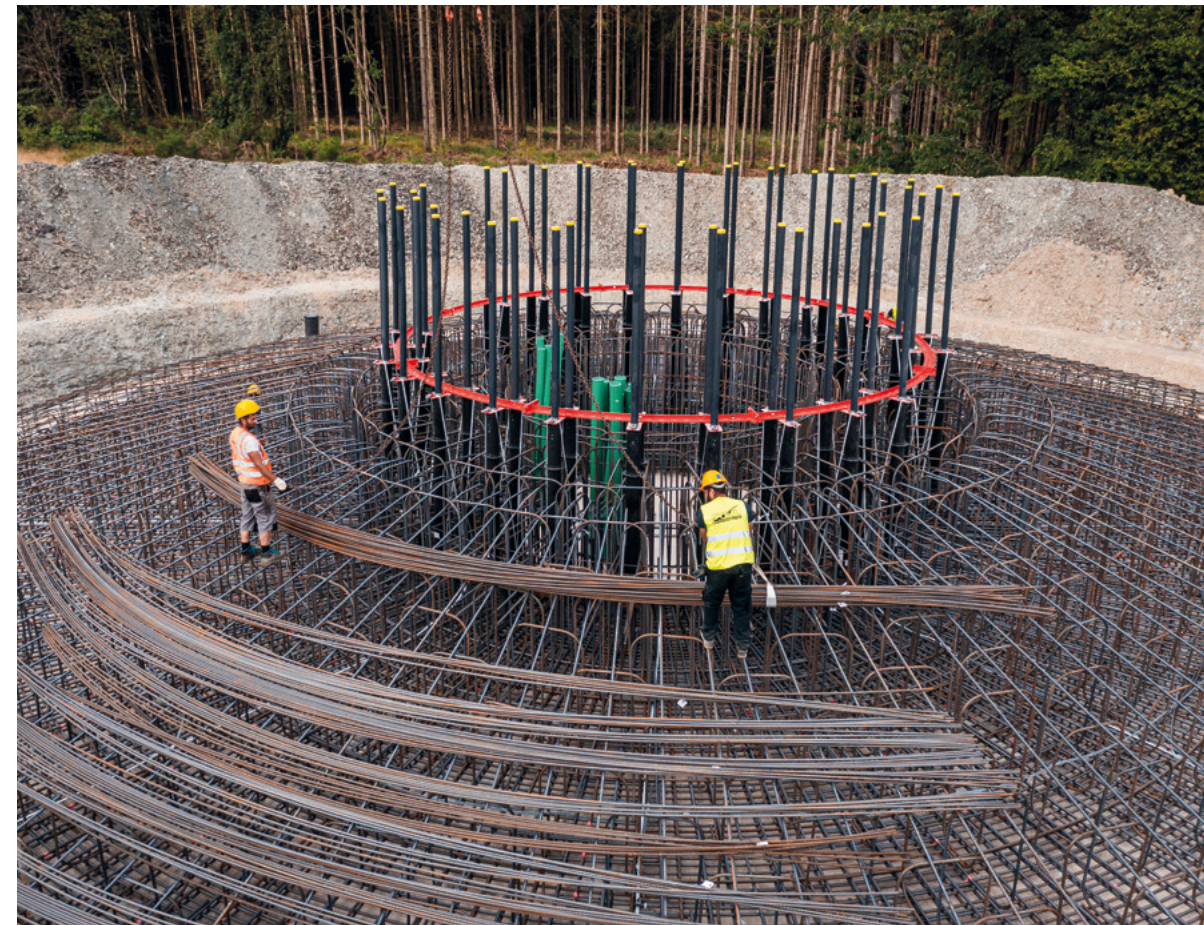
Der Fundamentkorb wird geflochten.
