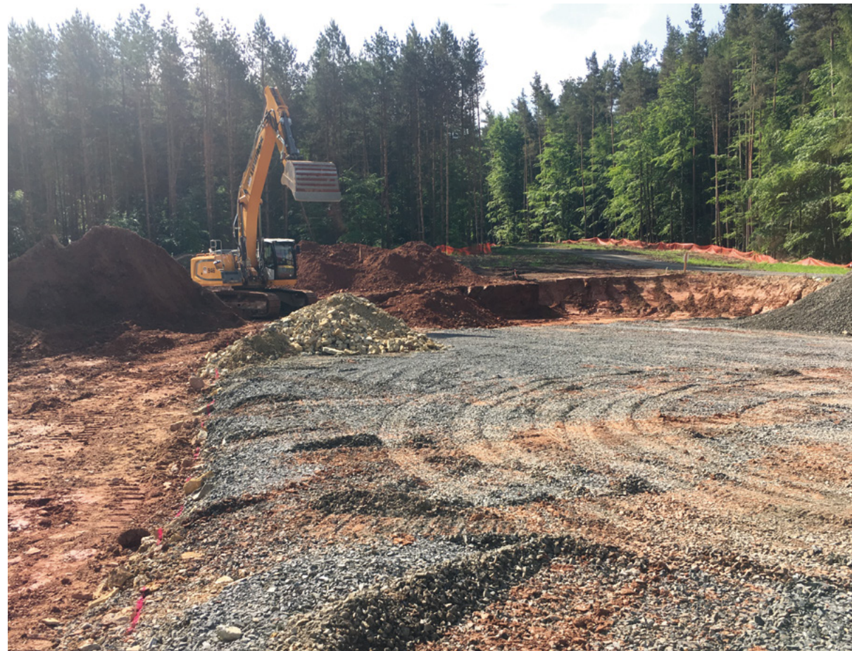
Der Standort wird für den Fundamentbau vorbereitet.
