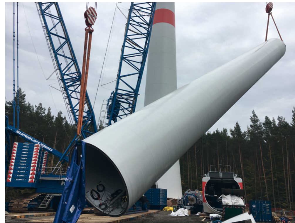
Montage eines Stahlturms
