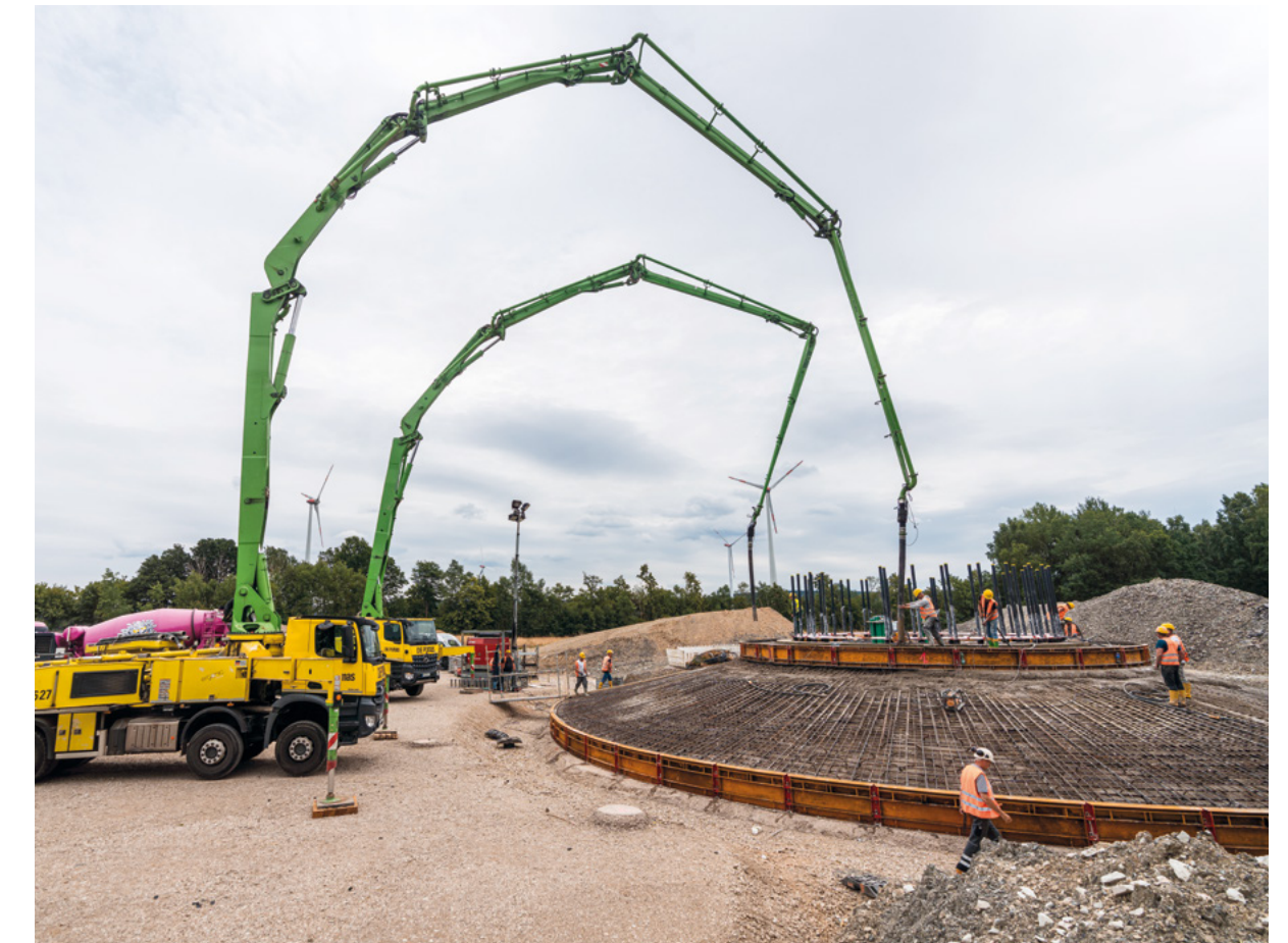
Betonage des Fundaments
