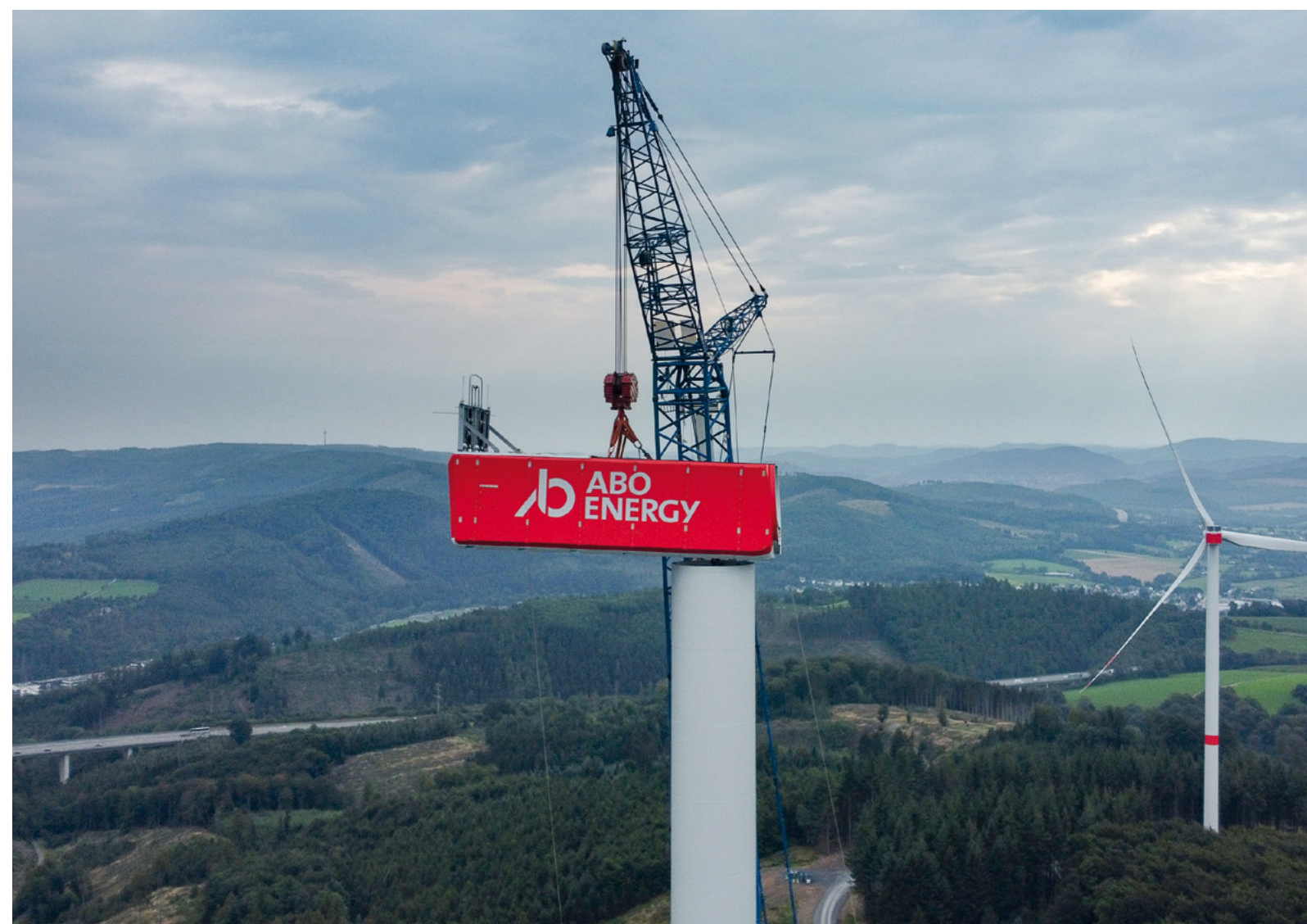
Montage des Maschinenhauses
