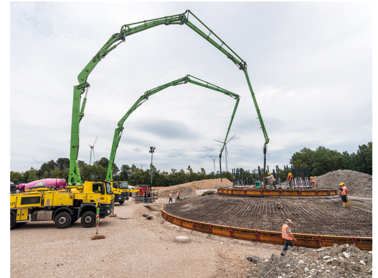
Betonage des Fundaments
