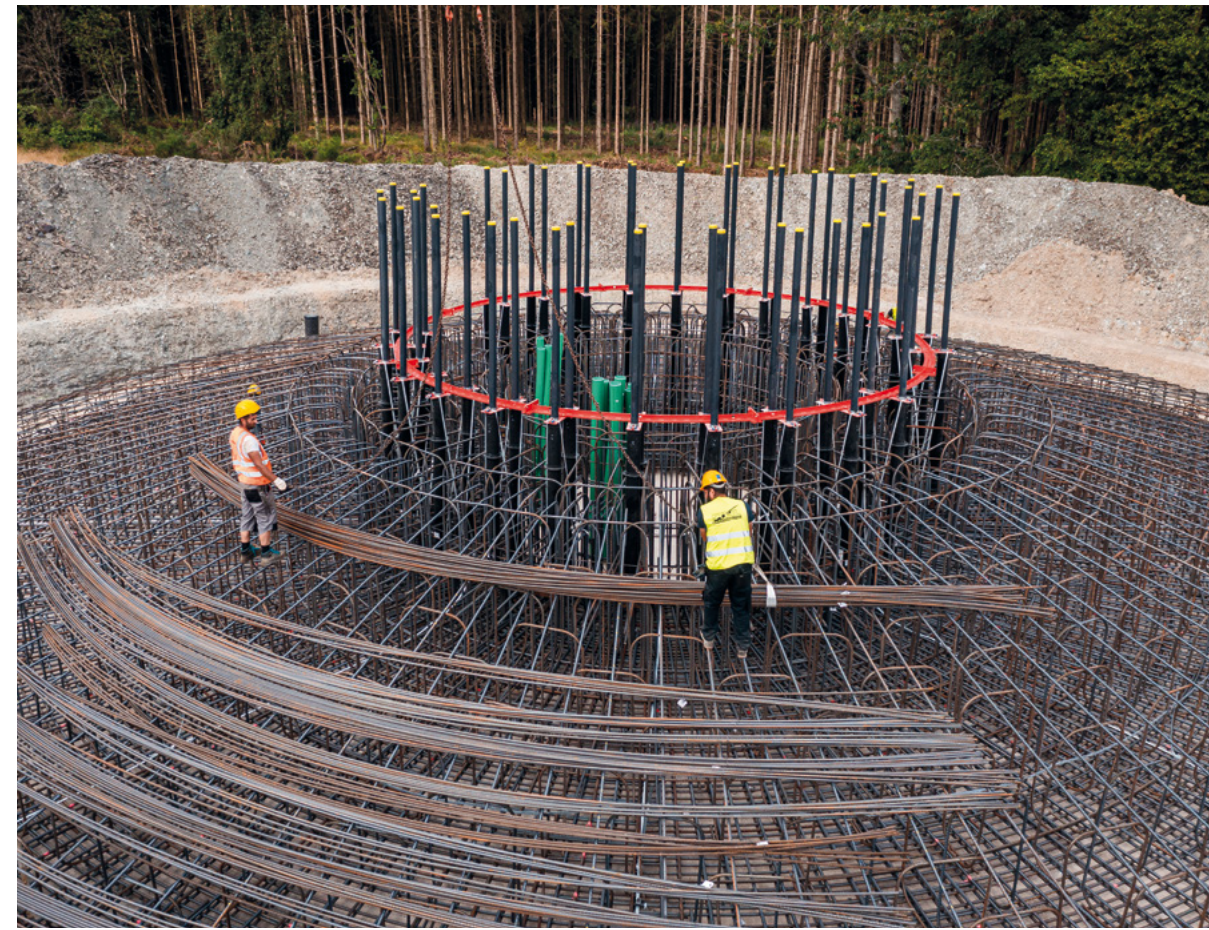
Der Fundamentkorb wird geflochten.
