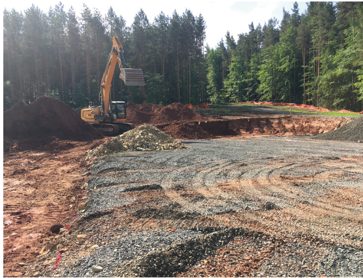
Der Standort wird für den Fundamentbau vorbereitet.
