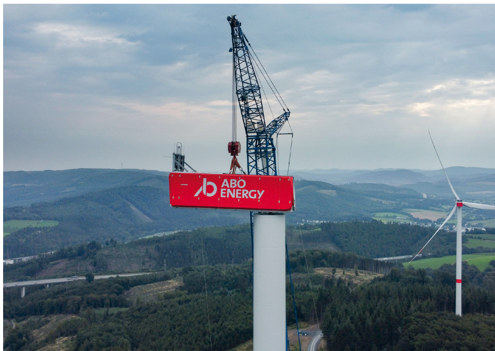
Montage des Maschinenhauses
