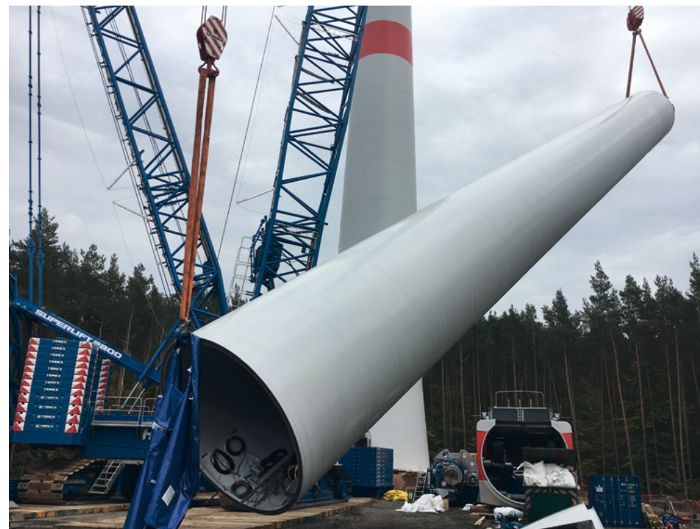
Montage eines Stahlturms
