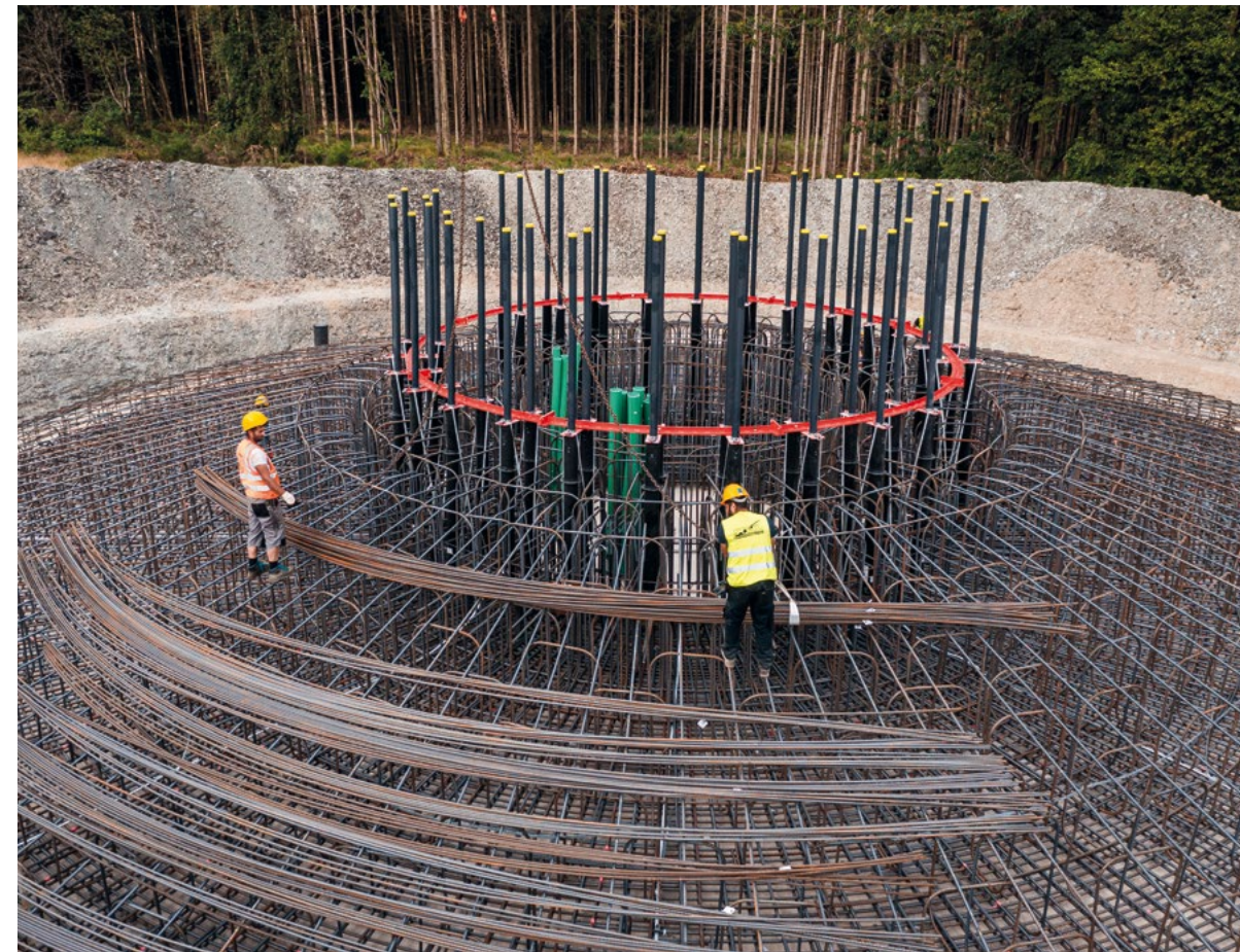
Der Fundamentkorb wird geflochten.
