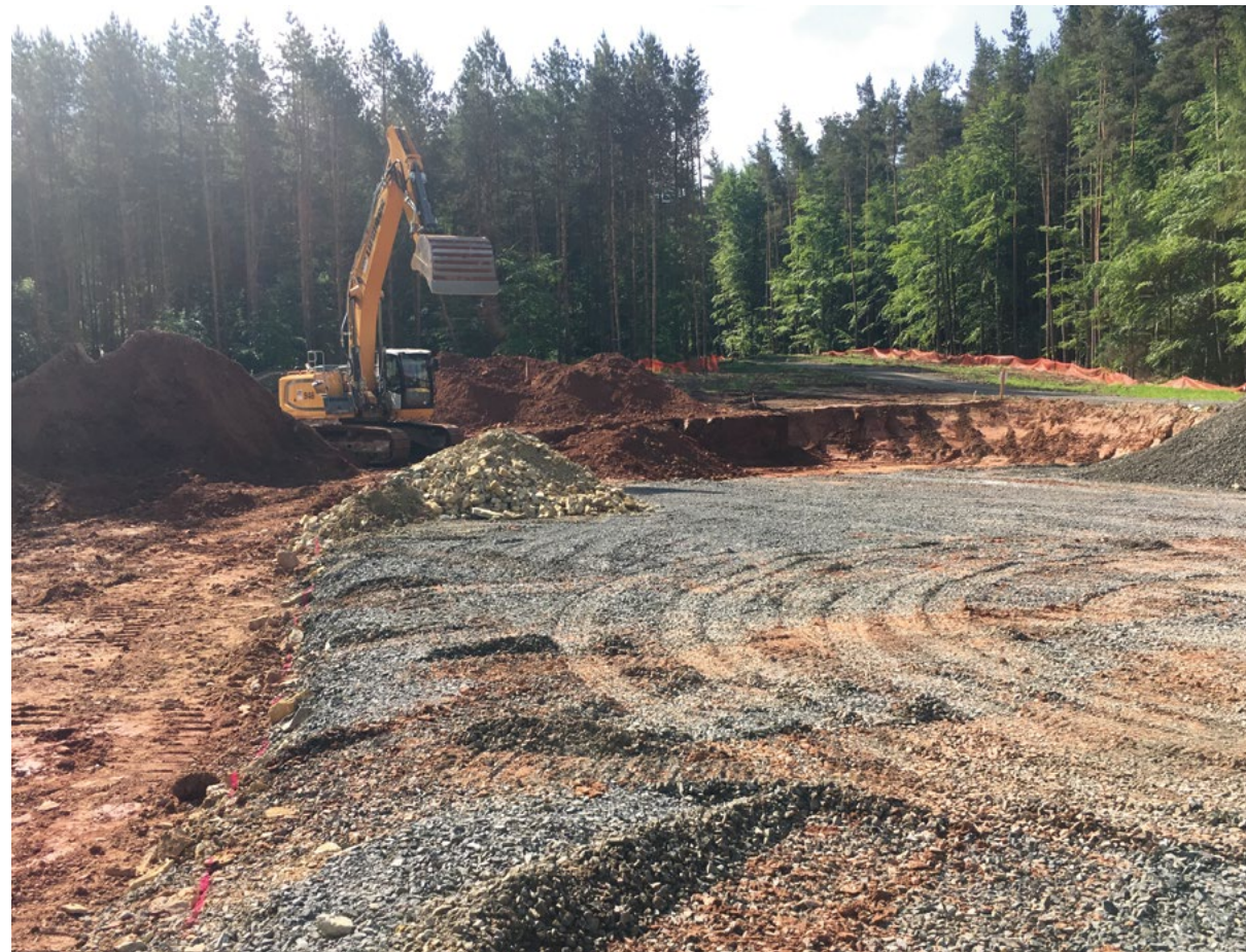
Der Standort wird für den Fundamentbau vorbereitet.
