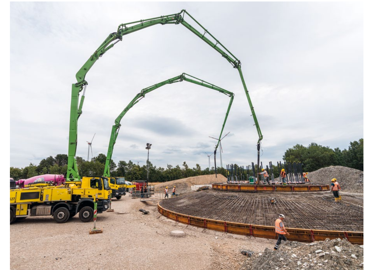
Betonage des Fundaments
