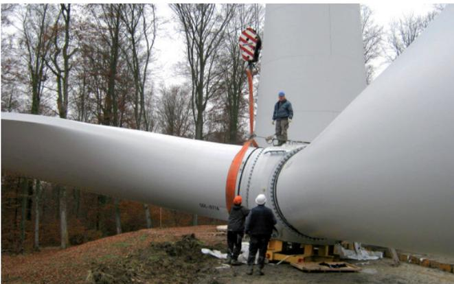
„Den Stern ziehen“ nennen Experten diesen Montageschritt, bei dem die Flügel an der Nabe befestigt werden.
