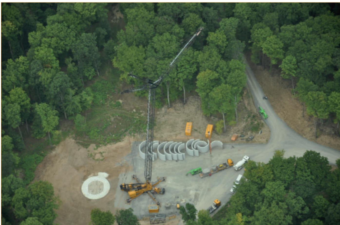
Ein Blick auf die Baustellen aus der Vogelperspektive: Links ist das Fundament der Anlage zu sehen, rechts die Beton-Halbschalen, aus denen die unteren 90 Meter des Hybridturms bestehen.
