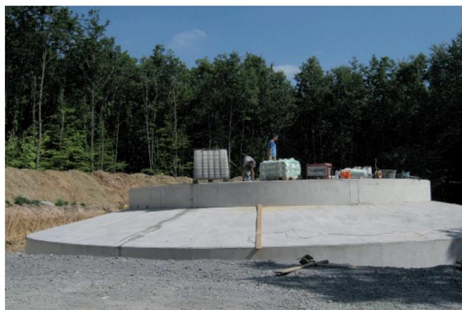
Auf einer Grundfläche von 400 Quadratmetern entsteht das Fundament einer Windkraftanlage. Der Durchmesser beträgt 21,5 Meter.
