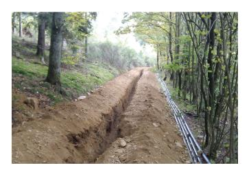
Damit der Strom von der Anlage ins Stromnetz eingespeist werden kann, wird eine Kabeltrasse verlegt. Der Graben wird in wenigen Wochen aber nicht mehr zu sehen sein.
