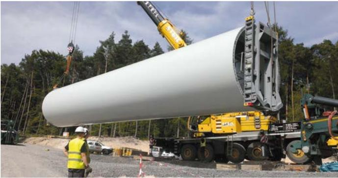
Der Turm mit seiner Gesamthöhe von 139 Metern besteht aus zwei Komponenten. Der untere, breite Teil wird aus Beton-Fertigteilen errichtet. Darauf wird der Stahlurm aufgesetzt. Diese so genannte Hybridtechnik ermöglicht es, über 100 Meter hohe Türme zu bauen.
