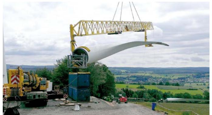
Wenn das Maschinenhaus auf den Turm gehoben wurde, werden als letzte Bauteile die Rotorblätter einzeln an der Nabe montiert. Die Methode der Einzelblatt-Montage ist, gegenüber der Vormontage des gesamten Rotors am Boden, platzsparend. Damit verringert sich die Fläche, die für die Bauarbeiten benötigt wird.
