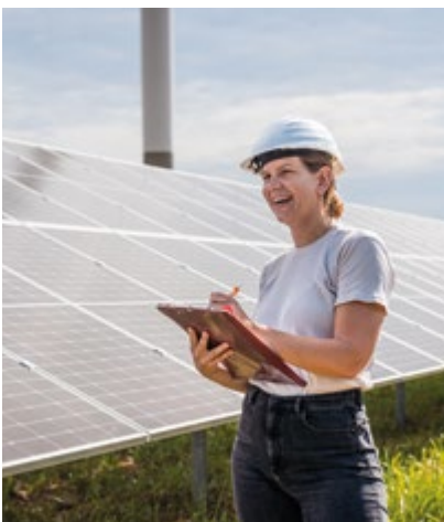
⬆️ Bau von Solaranlagen
