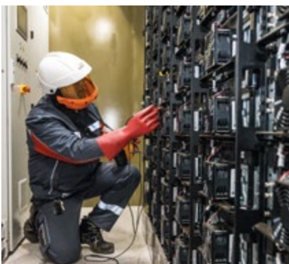
↑ Wartung eines Batteriespeichers
