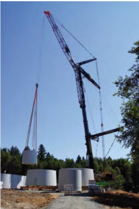
Die unteren 78,8 Meter des Turms bestehen aus Betonelementen. Die Schalen werden zunächst am Boden zusammengefügt und dann aufeinandergesetzt.
