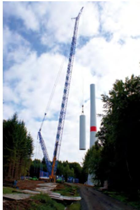
Mit den beiden Stahlrohrsegmenten erreicht der Turm seine Höhe von 136,80 Metern. Nun kann das Maschinenhaus aufgesetzt werden.
