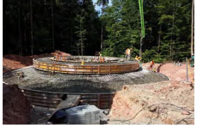
Nachdem die Bewehrung des Fundaments fertiggestellt wurde, wird die Konstruktion mit Beton ausgegossen.
