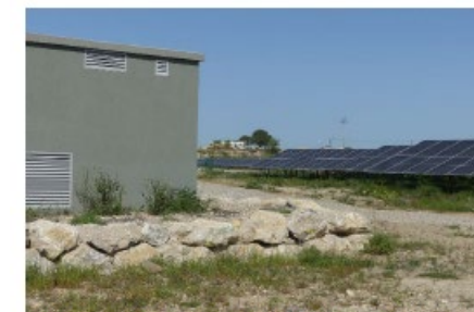
Aménagement du soubassement du poste de livraison au sein d'une centrale photovoltaïque au sol (L3) Yoann Blanchon (ARTIFEX), 2024
