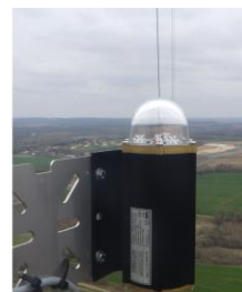
Balise Signalisation lumineuse aérienne
