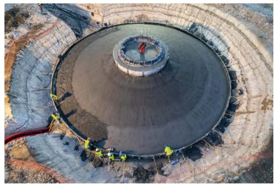
*Bétonnage des fondations (500-600 m3 par éolienne)*
